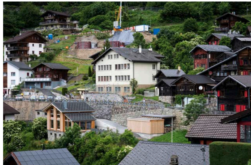
Dank dem neuen Konzept ist das Schulhaus Bratsch (Bildmitte) wiederbelebt. Elia begutachtet eine Handkurbel zur Stromerzeugung, die er selbst gebaut hat.
