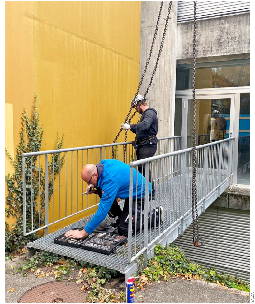
Re-Use: Eine Fussgängerbrücke wird für die Nutzung an anderer Stelle abgebaut.
